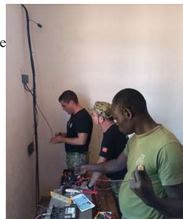
Figura 14 - Instalação CCTV na Residência de Santa Luzia- CDD
