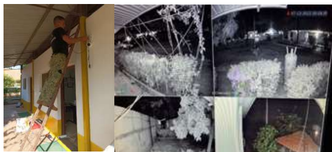
Figura 15 - Instalação CCTV na Residência de Santa Luzia- CDD
